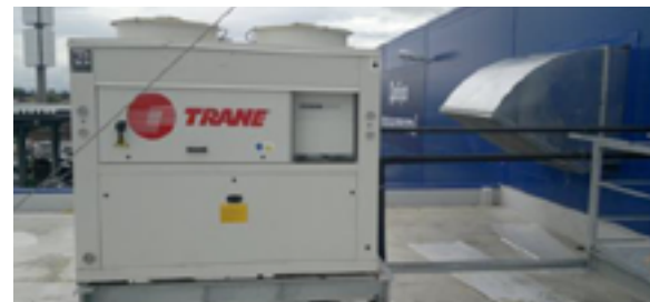
гр. Краснодар - преработка на чилър в комп.-кондензаторен блок на директно изпарение към климатична камера
