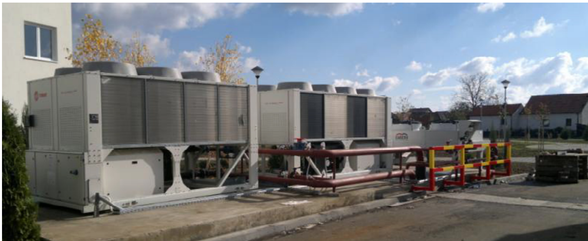
гр. Биелина - пуск и настройка на водоохлаждащи апарати за нова болница
