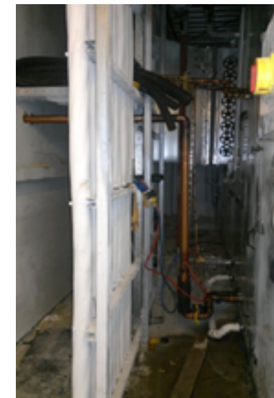
гр. Краснодар - преработка на чилър в комп.-кондензаторен блок на директно изпарение към климатична камера
