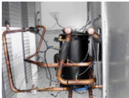
гр. Магнитогорск - преработка на чилър в комп.-кондензаторен блок на директно изпарение към климатична камера
