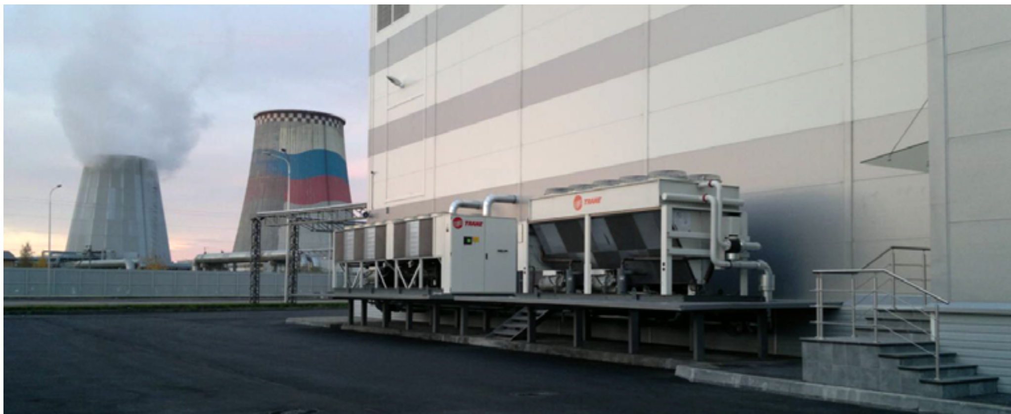
гр. Санкт Петербург - пуск и настройка на водоохлаждащи апарати за фармацевтична фабрика
